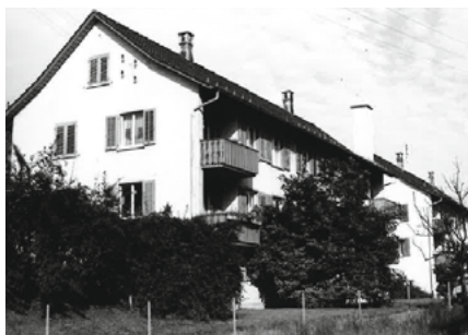
Neudorfstrasse 27–31 Aufnahme Archiv
